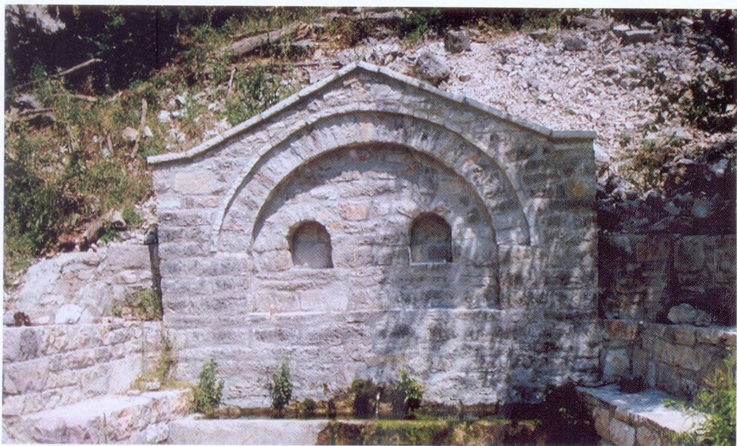
Εικόνα 14β. Η βρύση μετά τις εργασίες ανακαίνισης
