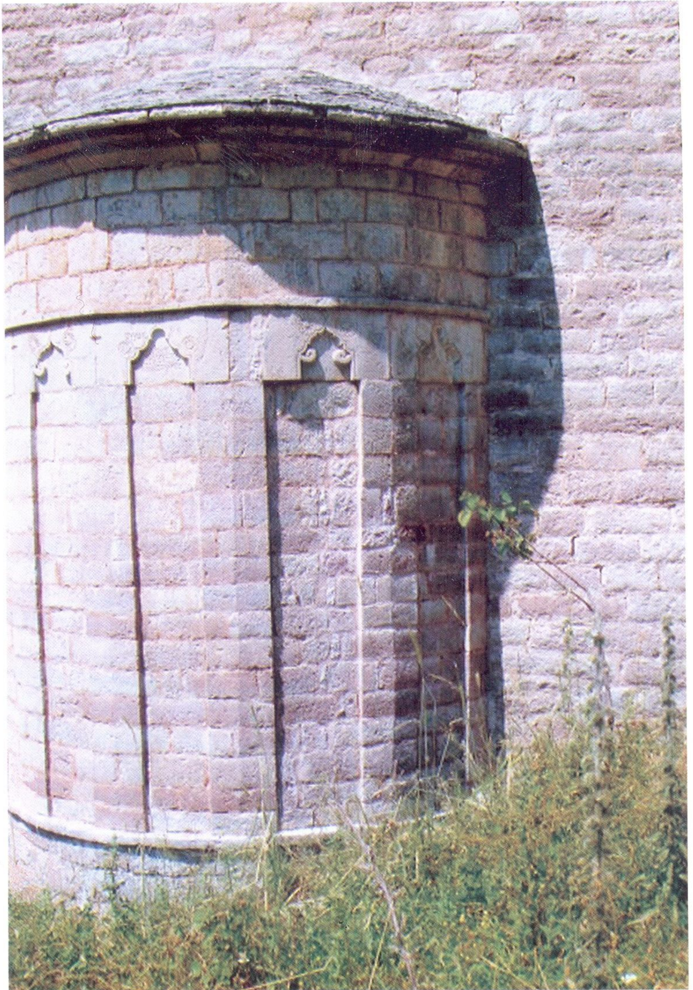
Εικόνα 9β. Η αψίδα του καθολικού της μονής μετά τις εργασίες αποκατάστασης
