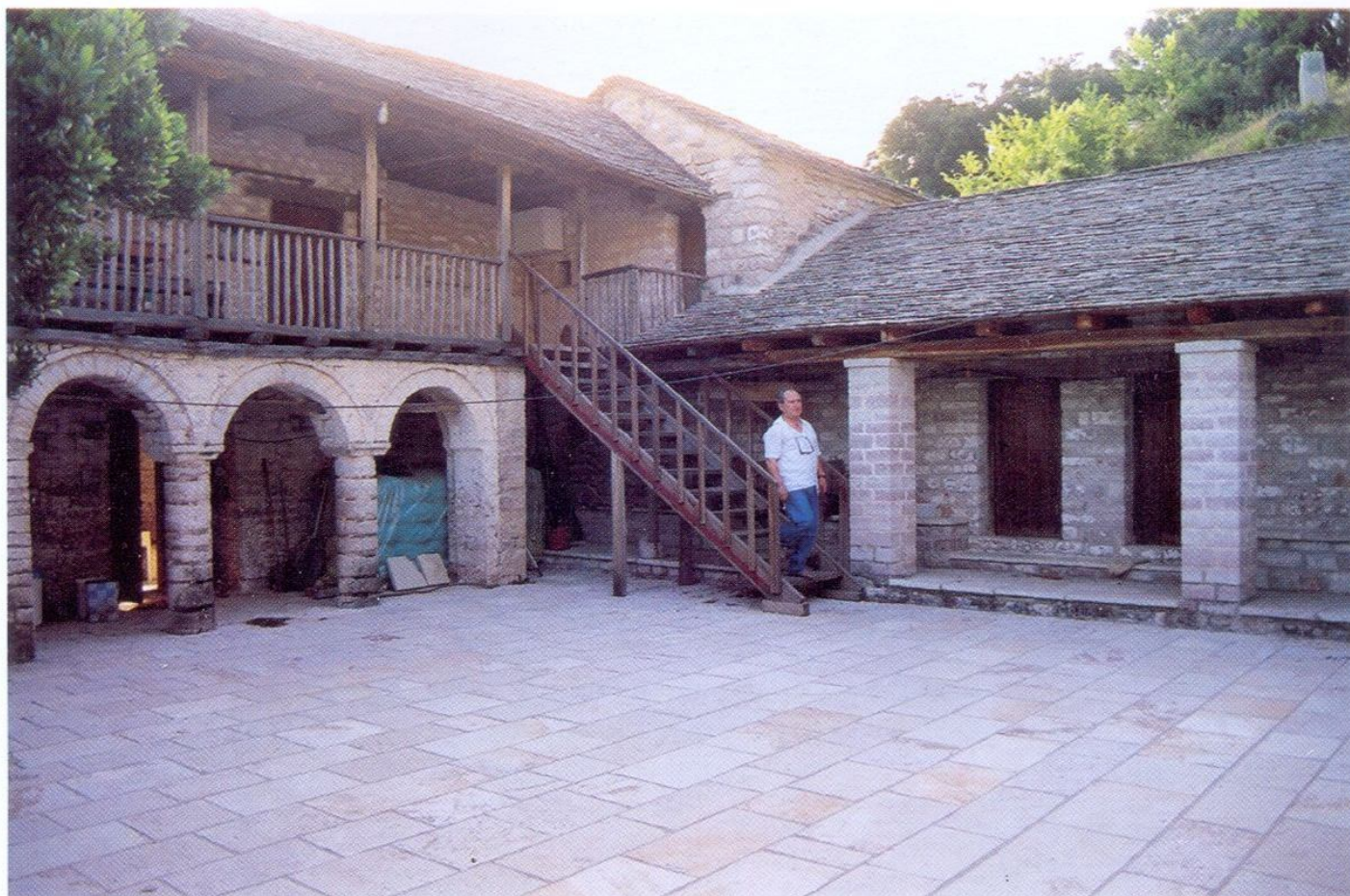
Εικόνα 10. Το νέο πλακόστρωτο δάπεδο της εσωτερικής αυλής
