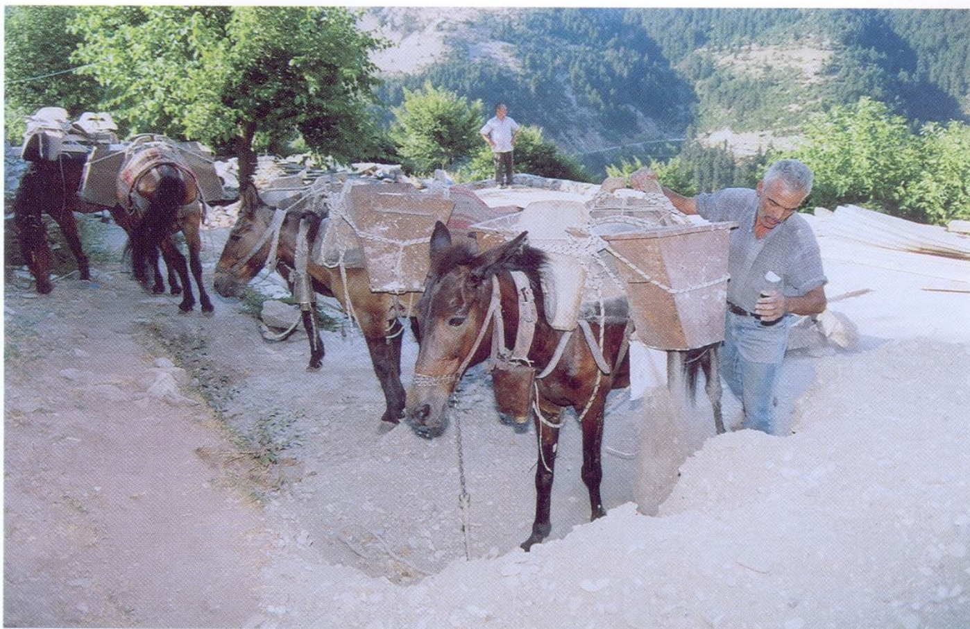
Εικόνα 5. Η μεταφορά με ζώα των υλικών για τις εργασίες ανακαίνισης της μονής
