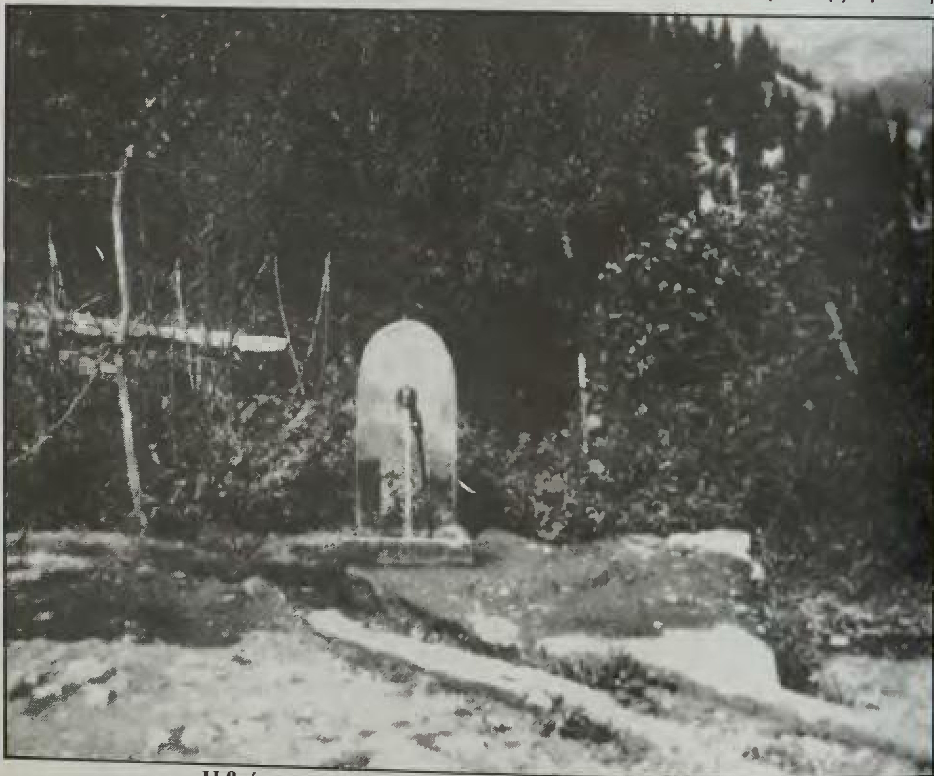
Η θρύση μπροστά στο σπίτι του Αναστάση Γ. Καλαντζή
