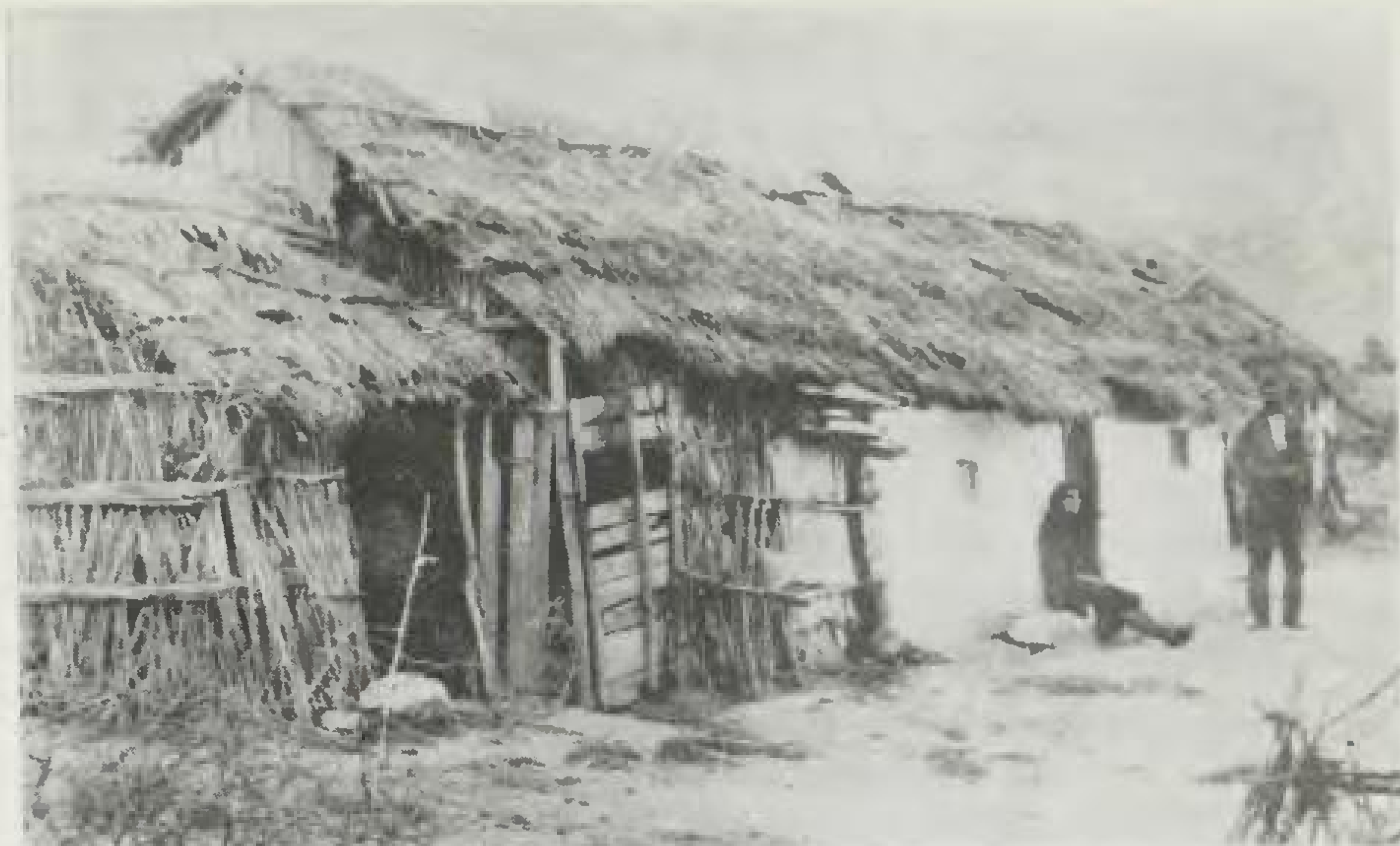
55. Βρυκολάκια Τρικάλων 1968: Παραδοσιακή καλύβα, κατασκευασμένη με τα ίδια πρωτόγονα μέσα και την τεχνική των Ομηρικών χρόνων, ήτοι ξύλα, βάλτος, βέργες, παλάμισμα.
