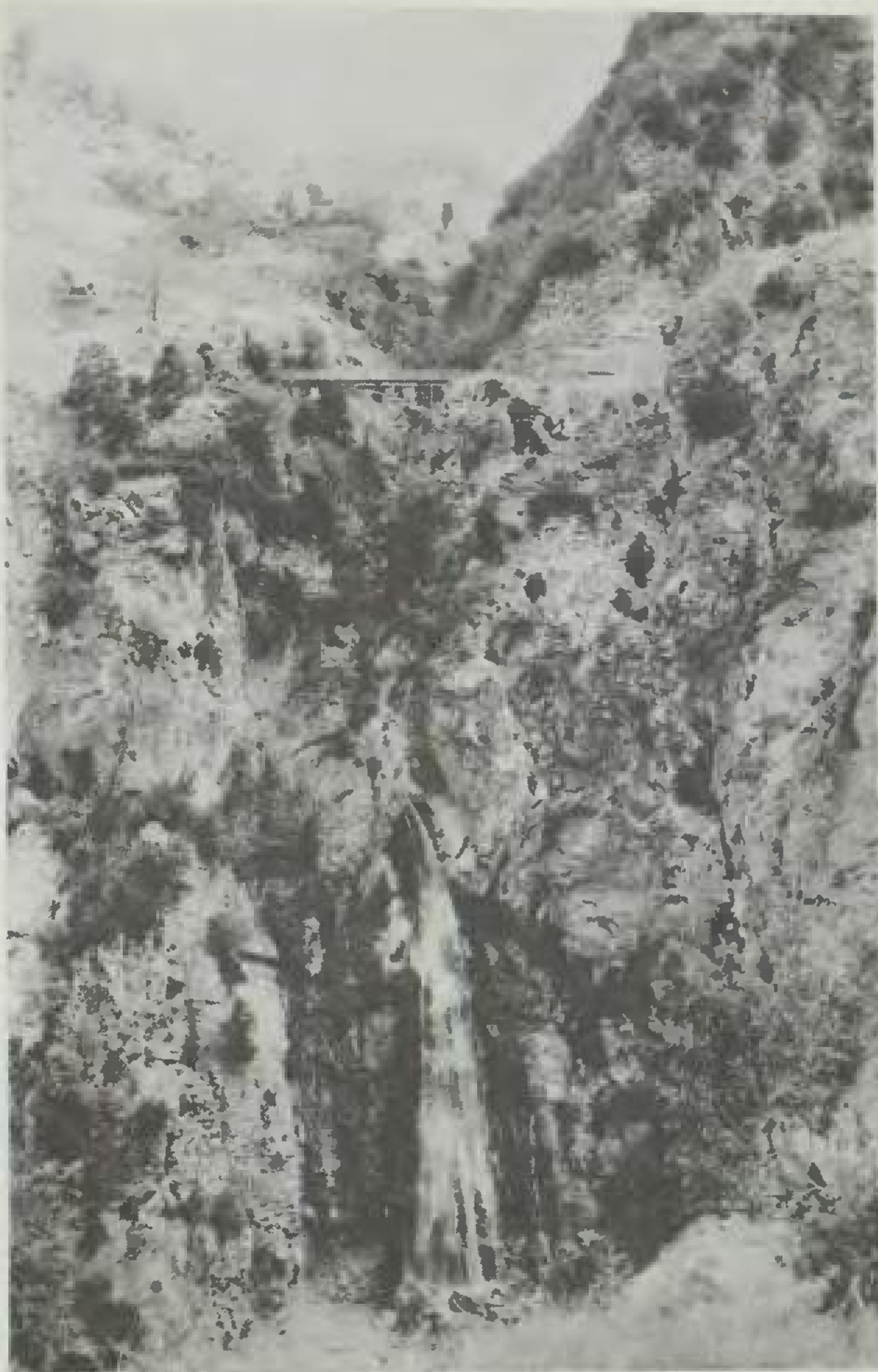
26. Η τιμεντένια αμαξιτή γέφυρα στο ποτάμι της Μαυριάς, πραγματική αετοφωλιά, κάτω ο καταρράκτης στο Καμίλι (4-8-1990).
