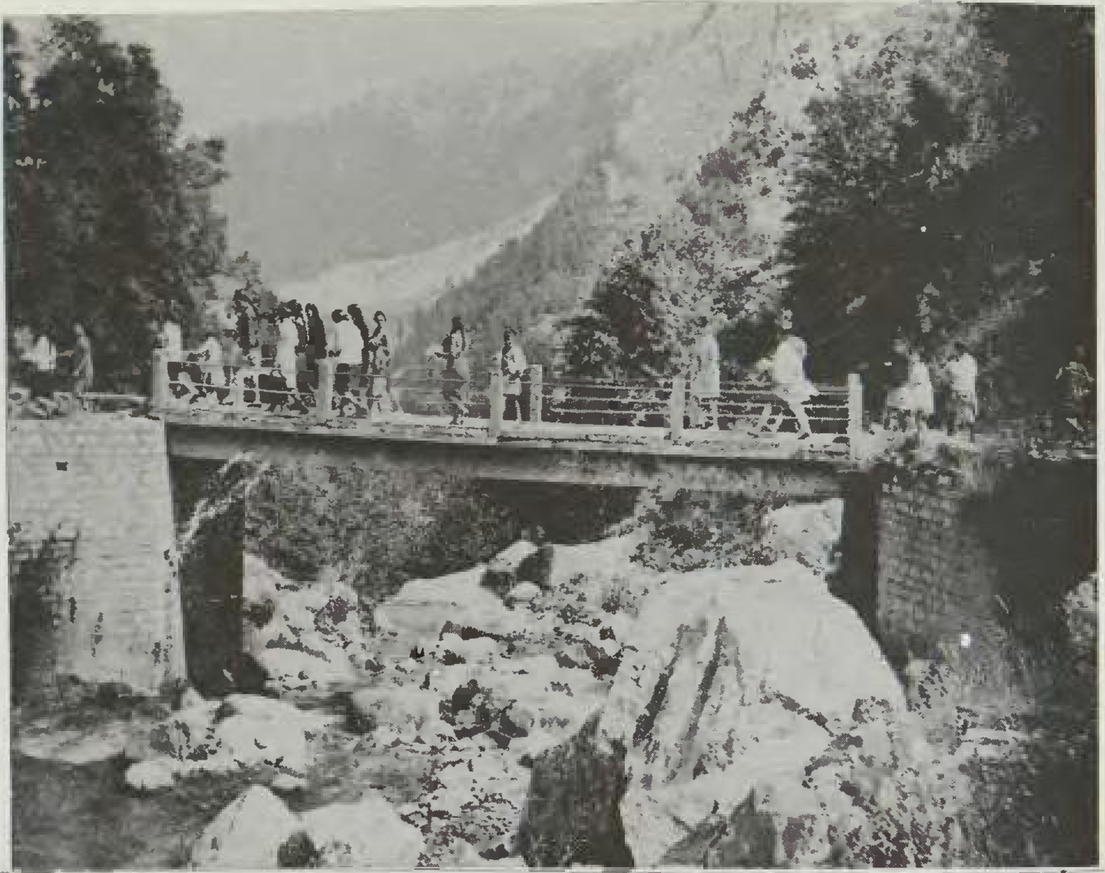
27. Το τσιμέντο εκτοπίζει το ξύλο. Εδώ στη γέφυρα του μύλου με τα υψώματα για την Θεία Λειτουργία στο εξωκλήσι του Αγίου Αθανασίου (6-8-1969).
