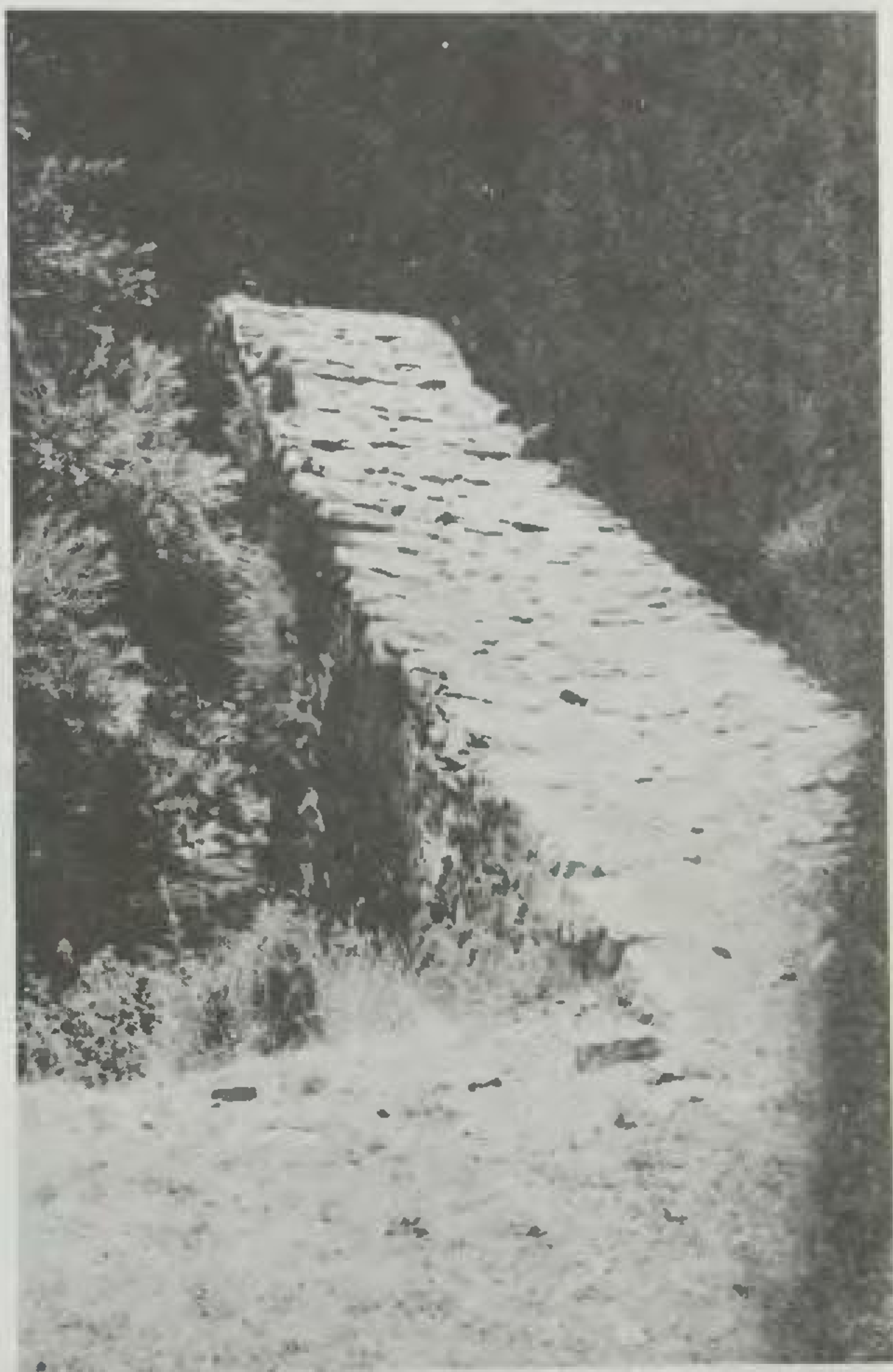
38. Παραδοσιακά πέτρινα γιοφυράκια «έσωζαν» τους ταξιδιώτες. Εδώ ολοπέτρινο γεφύρι του Ασπροπόταμου, κοντά στο Μοναστήρι της Παναγίας στην Λεπενίτσα (Ανθούσα) Καλαμπάκας: δυο καμάρες (ύψος μεγάλης 6.20 μ.), μήκος 23 μ. και πλάτος 2,50 μ. (24-7-1988).
