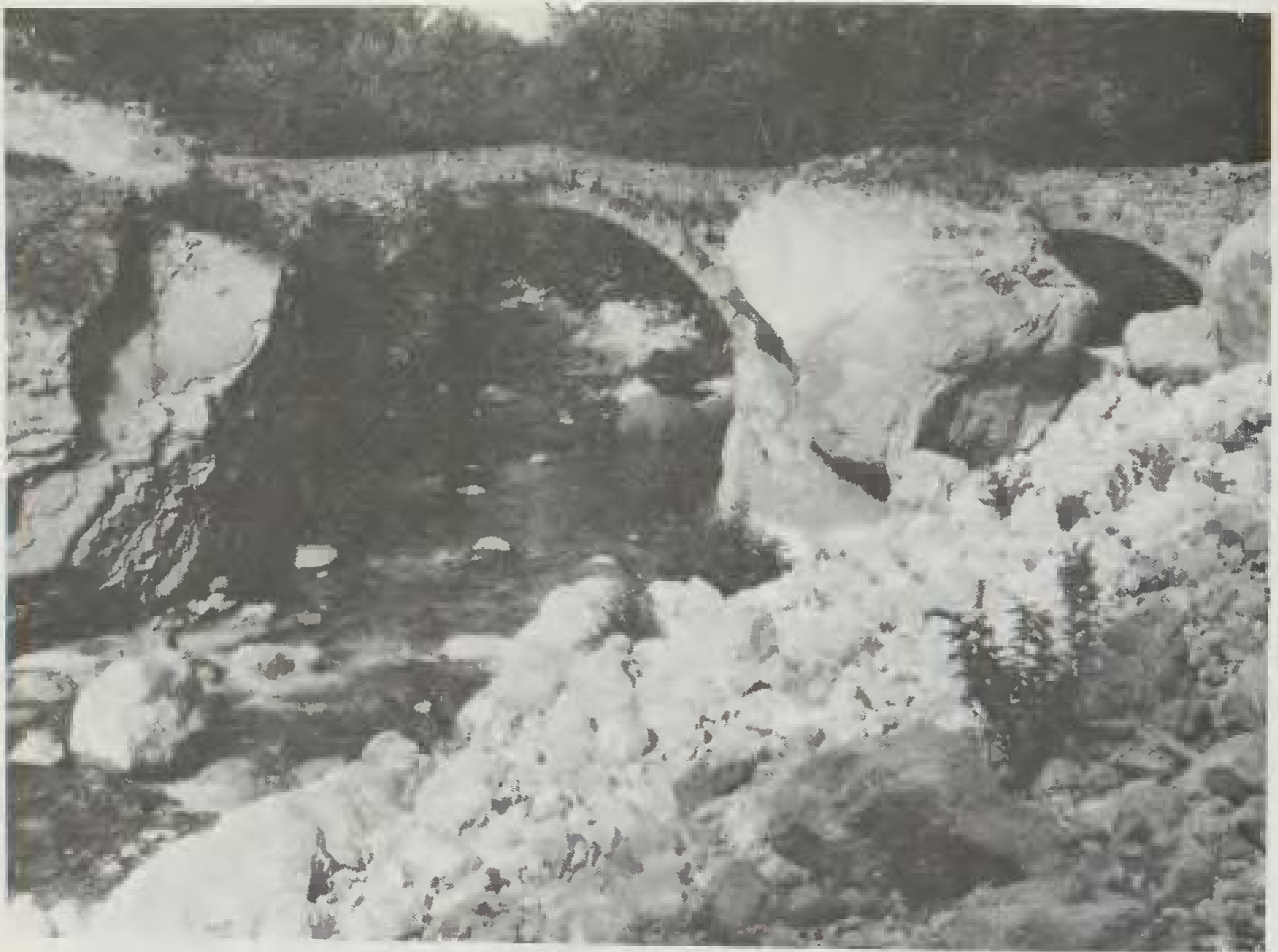
45. Το πέτρινο γεφύρι του Σταθμού στο Αρμπορούσι (27-8-1993).
