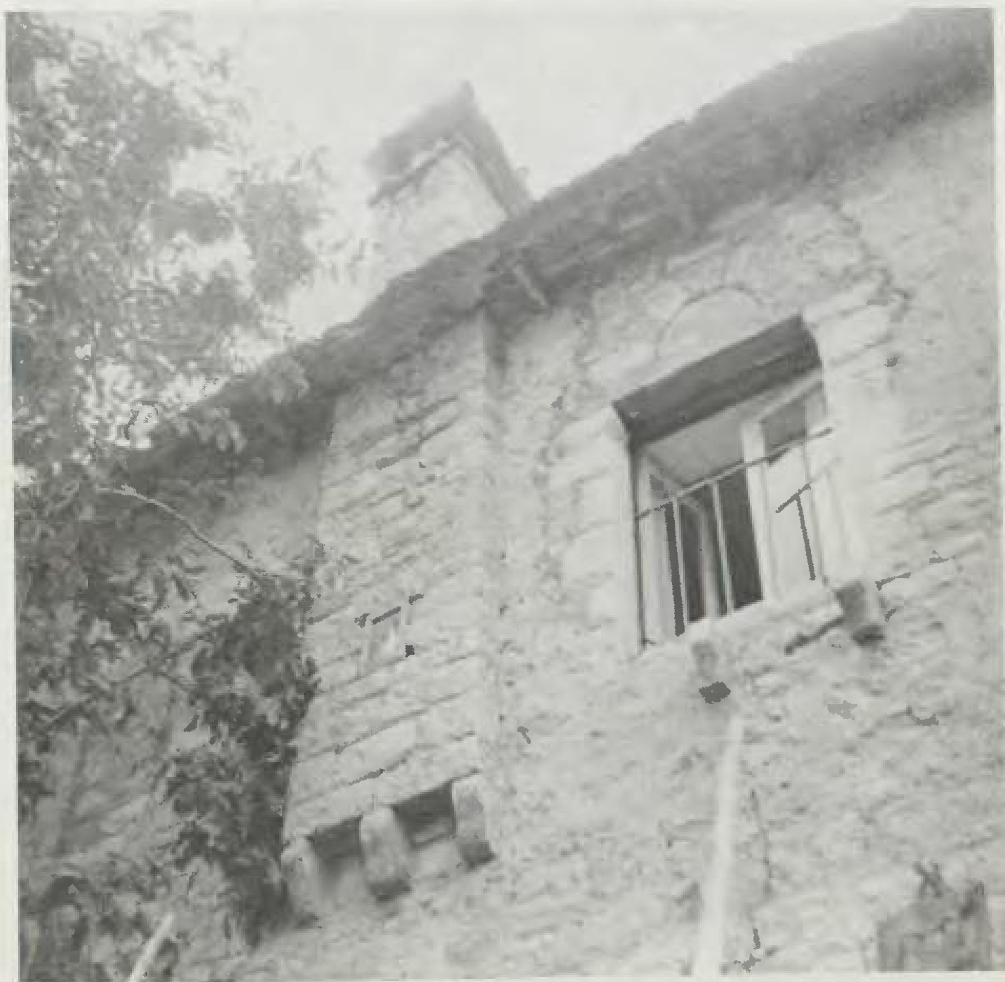
274. Ο μπουχαρής (με το μικρό φεγγίτη) προεξέχει στον εξωτερικό τοίχο του 1925, μοναδική ανυπακοή στην πέτρινη μονολιθικότητα (10-7-1985).
