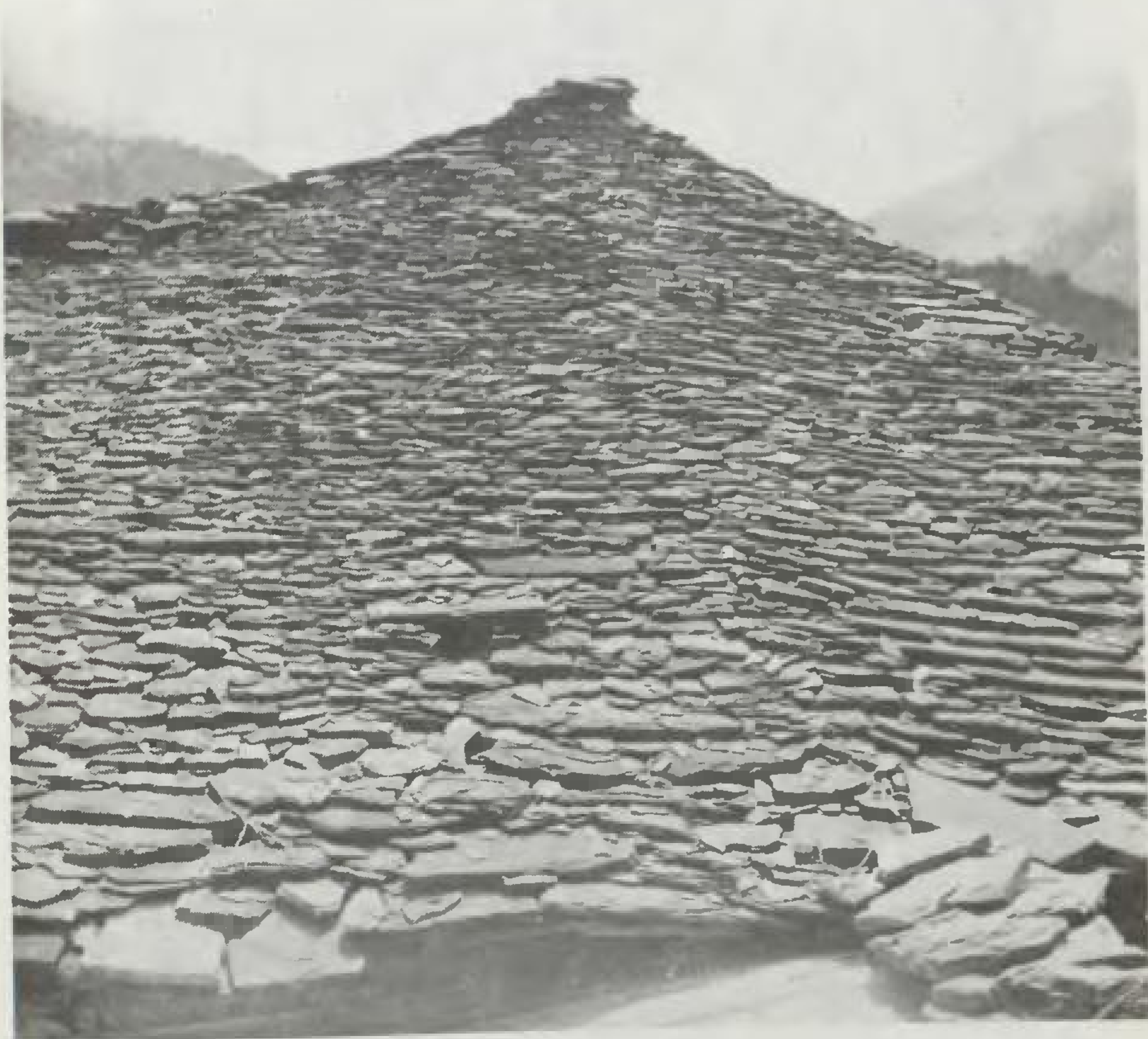
268. Ανάμεσα στις πλάκες της σκεπής του 1925 ανοίγεται και ένας μικρός φεγγίτης (17-7-1986):
