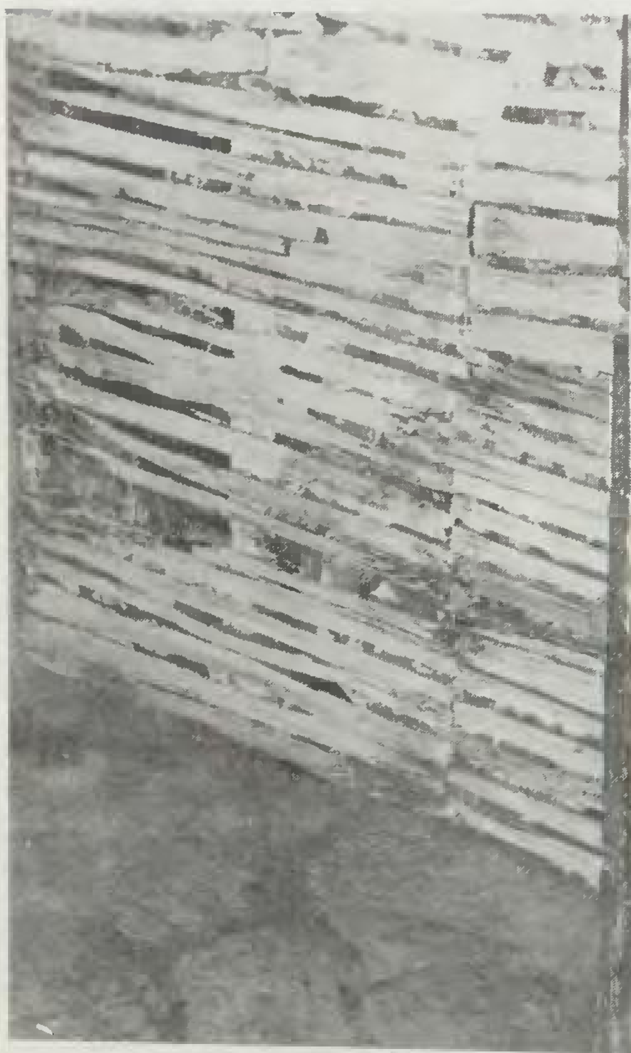
270. Κατώι: πλακόστρωτο δάπεδο, χώρισμα με πέλες (18-7-1986).
