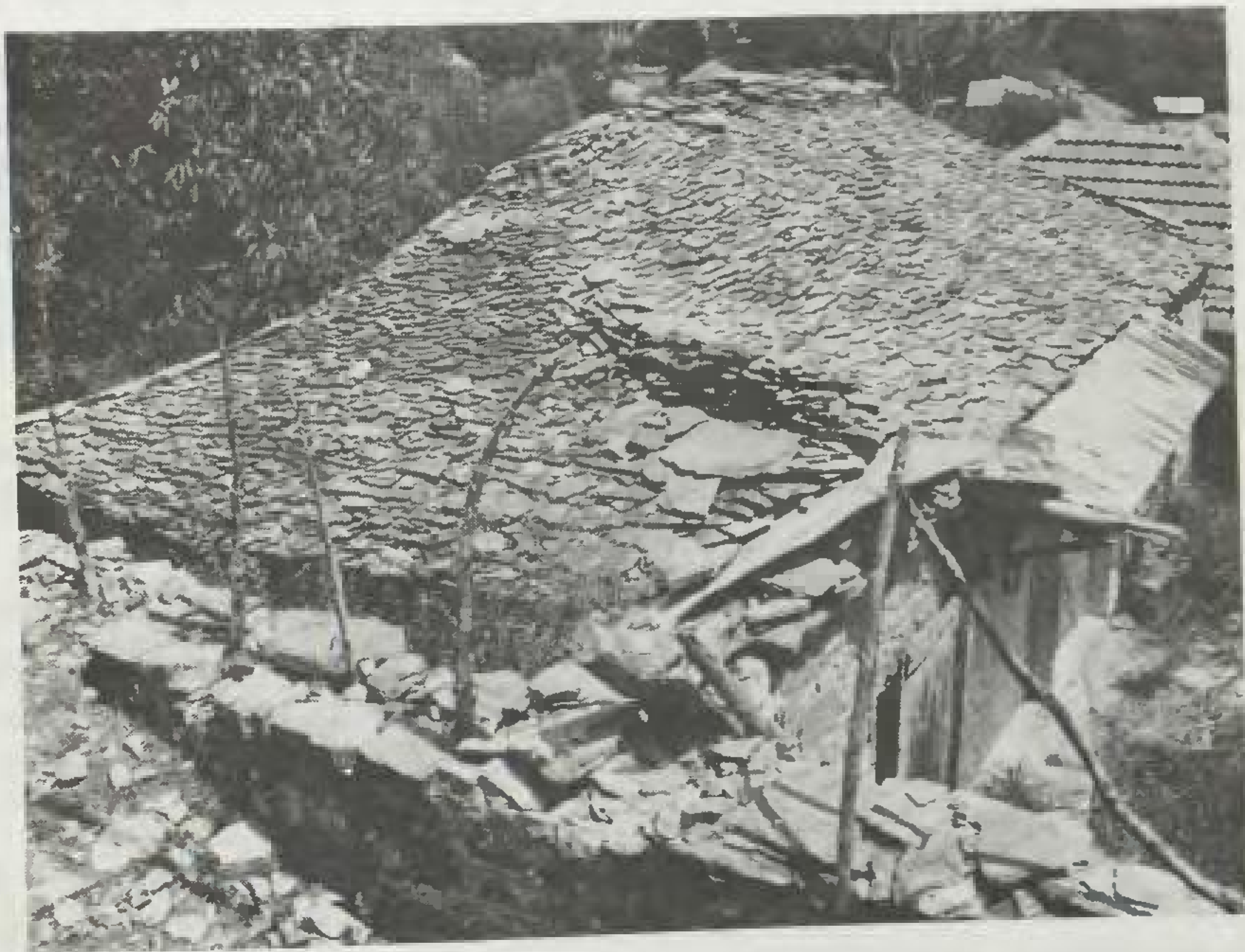
375. Ελάχιστες σήμερα οι πέτρινες στέγες, αλλά και αυτές σιγά-σιγά καταρρέουν από την εγκατάλειψη (4-8-1990). Στα ξύλα η σίτα, για προφύλαξη
