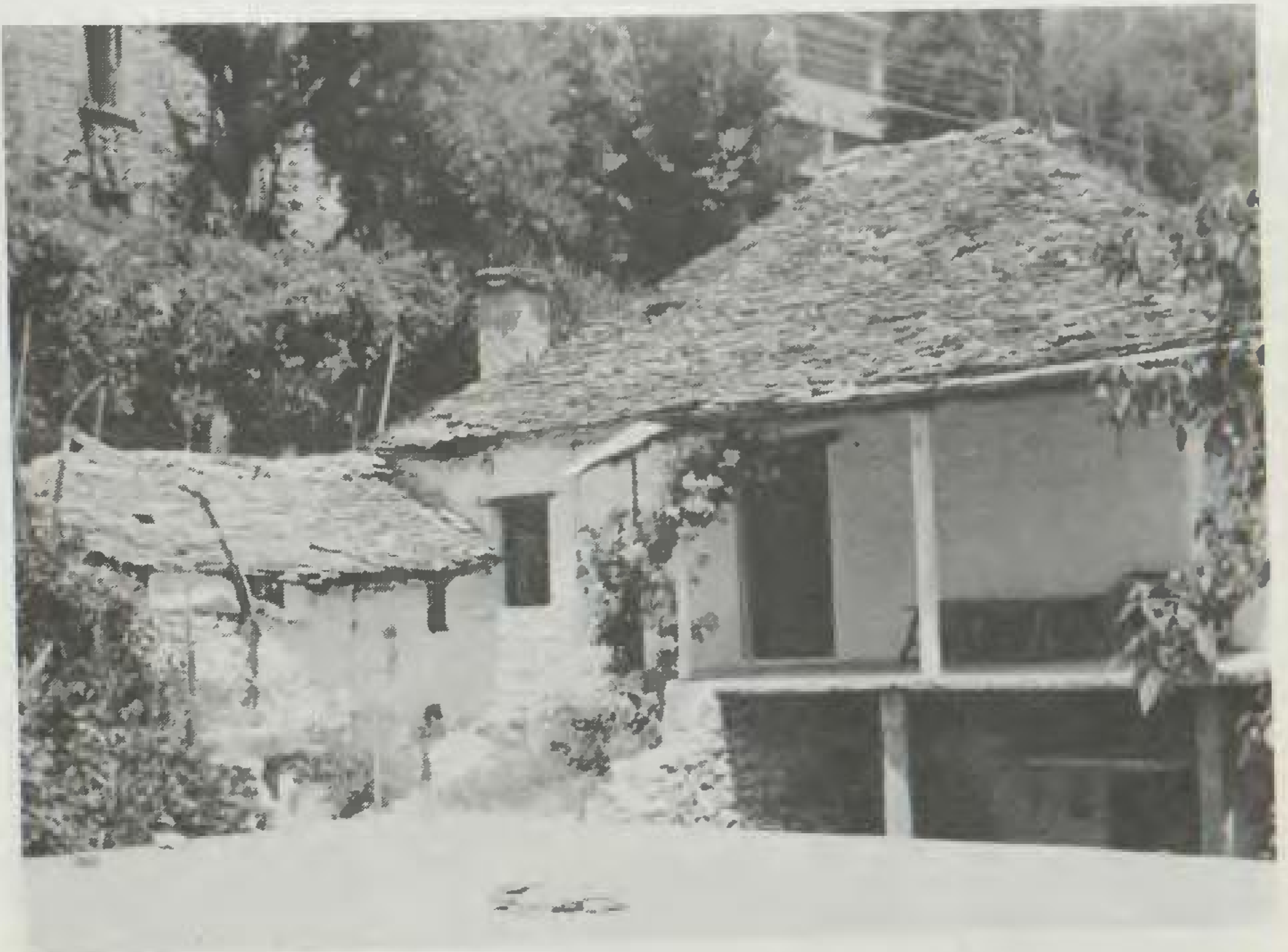
279. Δίπλα στο σπίτι βρίσκεται το μαγειριό, οίκημα ξέχωρο. Και στα δυο κτίσματα διακρίνεται ο φεγγίτης της σκεπής (10-7-1985).
