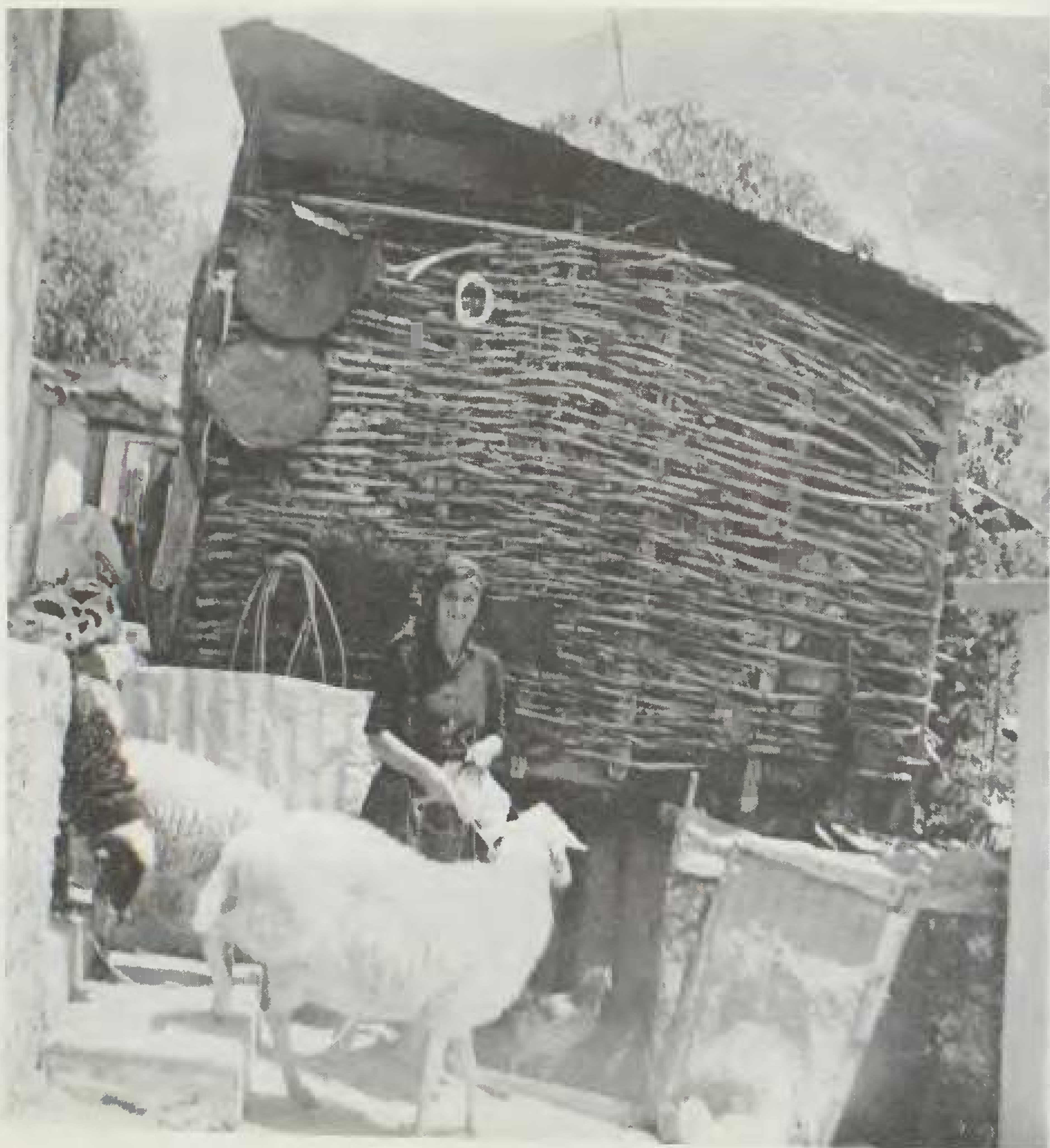
257. Σταύλος-κοτέτσι: Ο τοίχος πλεγμένος με βέργες, ενδιάμεσα πετρούλες, η πολυκαιρία και κακοκαιρία κατέφαγαν το παλάμισμα (10-7-1985).
