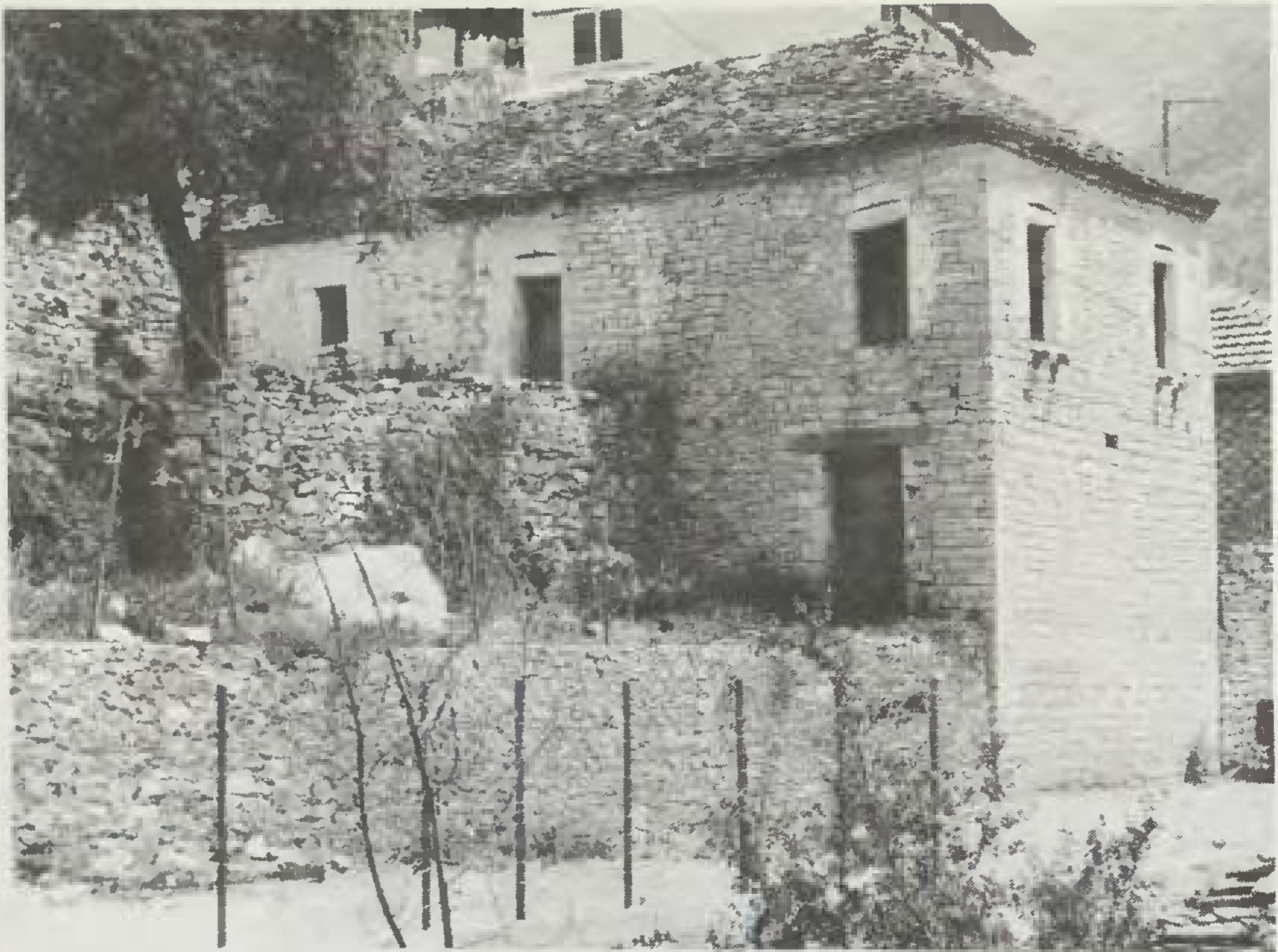
277. Στο κάτω μέρος σε καθένα από τα δυο παράθυρα, που είναι προς το δρόμο, εξέχουν από δυο πέτρες, για να εξυπηρετούν την τοποθέτηση λουλουδιών (4-8-1990).
