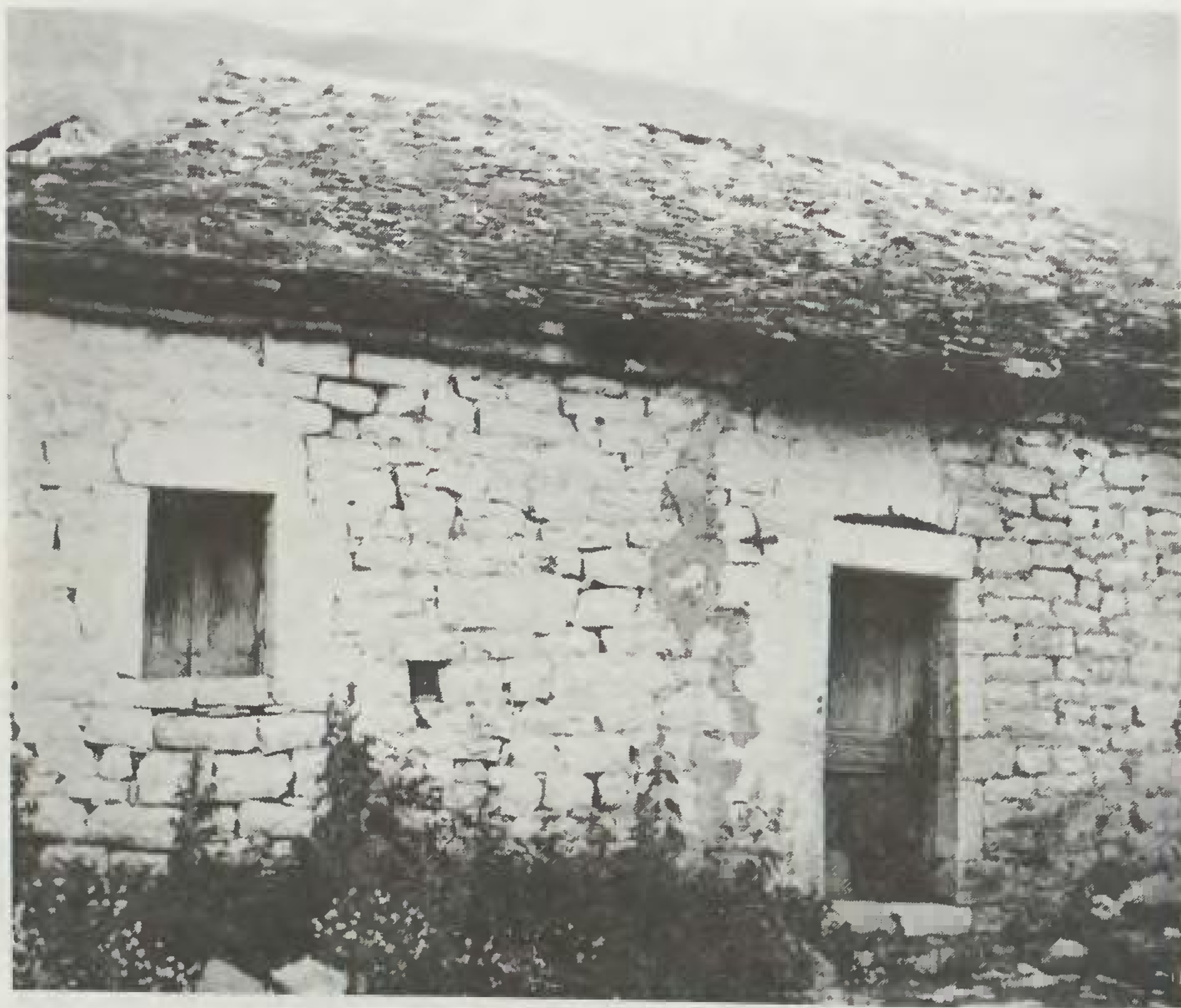
267. Πέτρινα πλακώματα, παράθυρο πολύ μικρό και χωρίς τζάμια, διπλά γριπίδια (10-7-1985).
